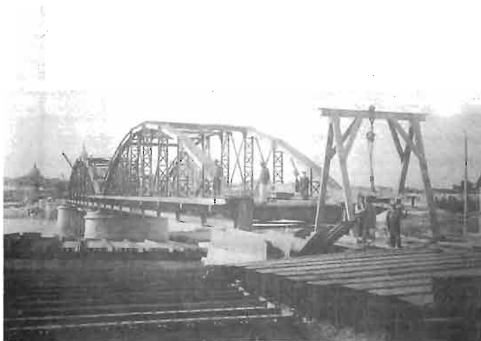
Foto 6.- Montaje de piezas metálicas, hacia 1907. (Foto Ruiz de Luna. Colección Consejería de O. P.).
