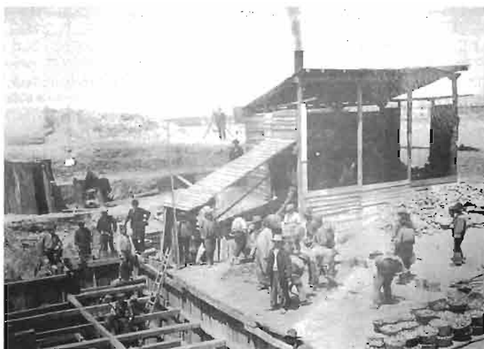
Foto 3.- Construcción del estribo de la margen izquierda, 1904. (Foto Ruiz de Luna. Colección Consejería de Obras Públicas).
