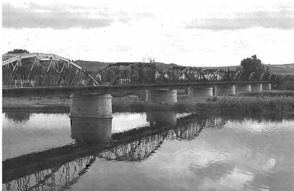
Foto 7.- Vista general del puente durante la remodelación de 1994. (Foto Alberto Moraleda).
