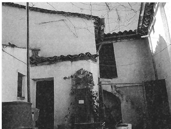
Vista exterior del pintador. (Foto autor).
