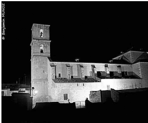
Fachada sur. Iglesia parroquial de San Blas. Valdeverdeja.
