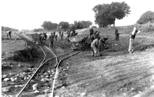
*En la imagen puede verse a los presos de la brigada de tierra picando y las mulas tirado de la vagonetas sobre railes para transportar la tierra.*
