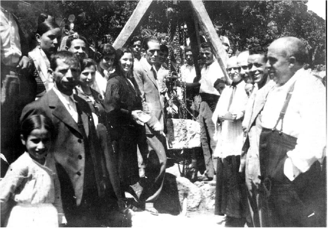
Fig. 2. Acto de colocación de la primera piedra de las escuelas el 25 de julio de 1934, festividad de Santiago Apóstol, marginando a la Corporación municipal candeledana, de mayoría radical-socialista, que había gestionado y pagaría la construcción de las Escuelas (Foto cedida por Luis Sánchez).
