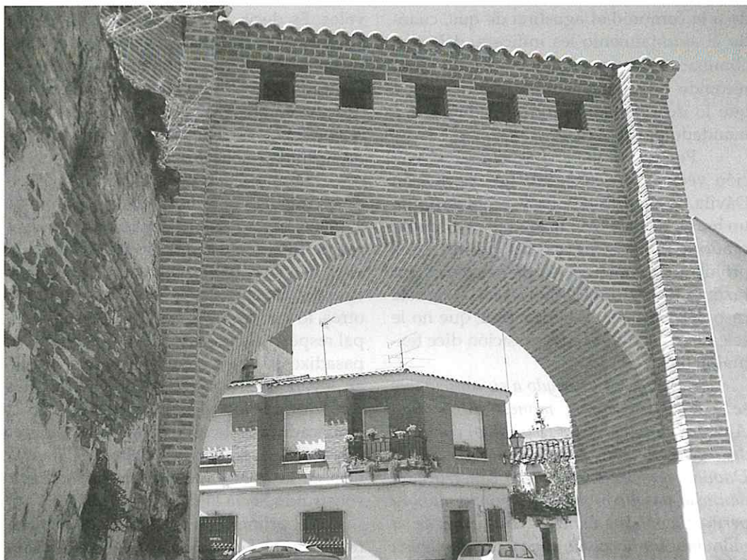
Pasadizo de San Agustín, reconstruido, cara este. (FOTO: COLECTIVO ARRABAL)
